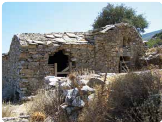
Εικόνα 1. Η δυτική όψη του ναού εξωτερικά.
